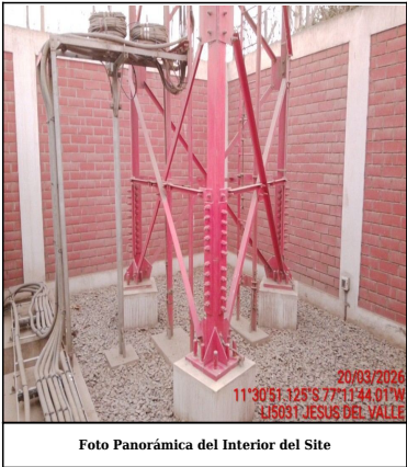
Foto Panorámica del Interior del Site
