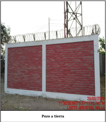
Pozo a tierra
