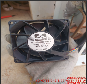
FOTO CORRIENTE SEGUN PLACA EN MOTOR VENTILADOR
