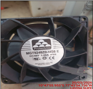
FOTO CORRIENTE REAL EN MOTOR VENTILADOR
