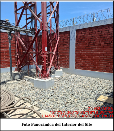
Foto Panorámica del Interior del Site
