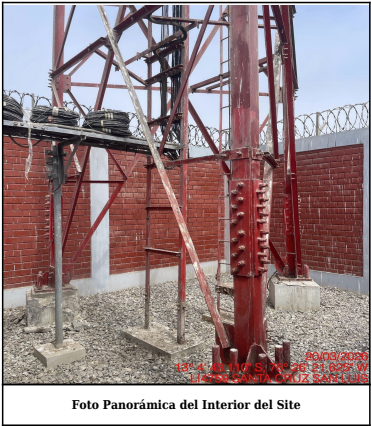
Foto Panorámica del Interior del Site
