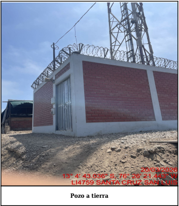
Pozo a tierra
