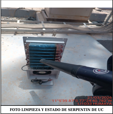
FOTO LIMPIEZA Y ESTADO DE SERPENTIN DE UC
