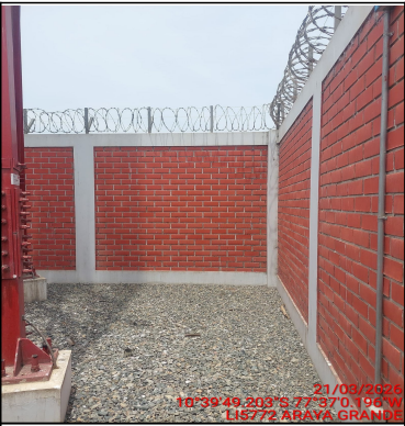
Foto Panorámica del Interior del Site
