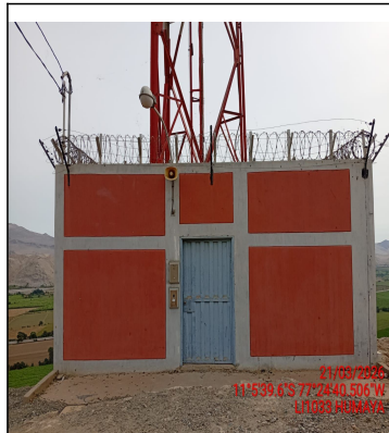
VISTA PANORAMICA DEL SITE
