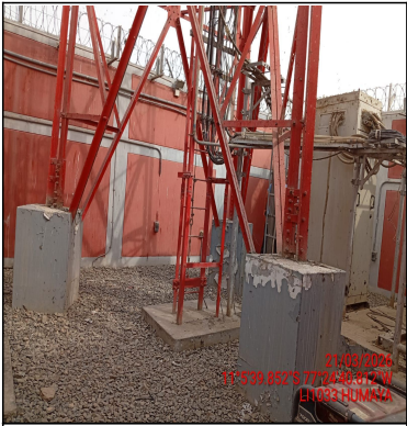
Foto Panorámica del Interior del Site
