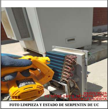
FOTO LIMPIEZA Y ESTADO DE SERPENTIN DE UC
