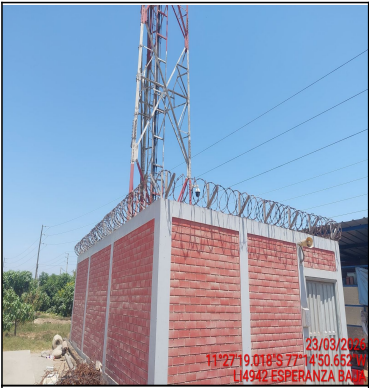
Pozo a tierra
