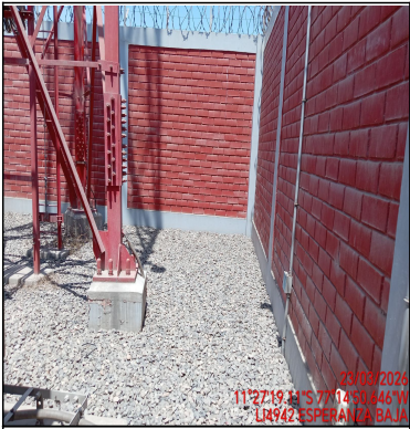
Foto Panorámica del Interior del Site
