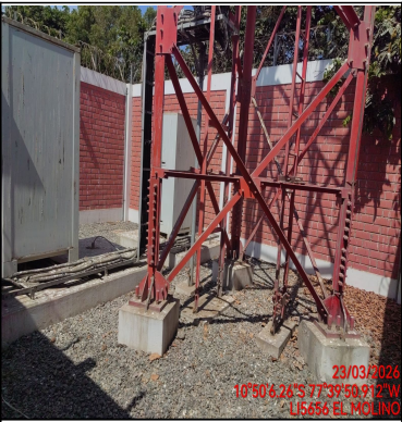
Foto Panorámica del Interior del Site
