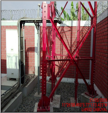
Foto Panorámica del Interior del Site
