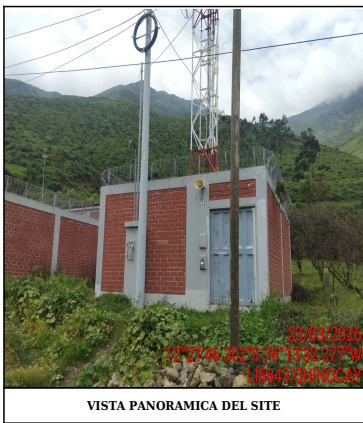
VISTA PANORAMICA DEL SITE
