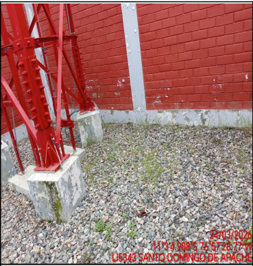
Foto Panorámica del Interior del Site
