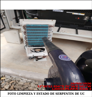
FOTO LIMPIEZA Y ESTADO DE SERPENTIN DE UC
