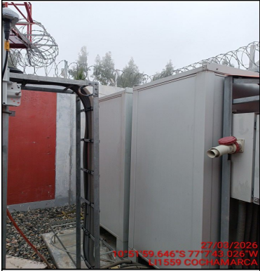
Foto Panorámica del Interior del Site
