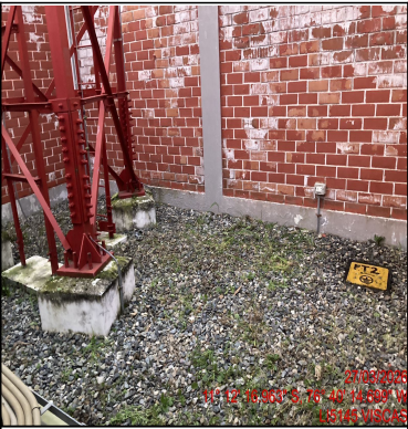
Foto Panorámica del Interior del Site
