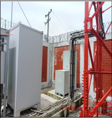
Foto Panorámica del Interior del Site
