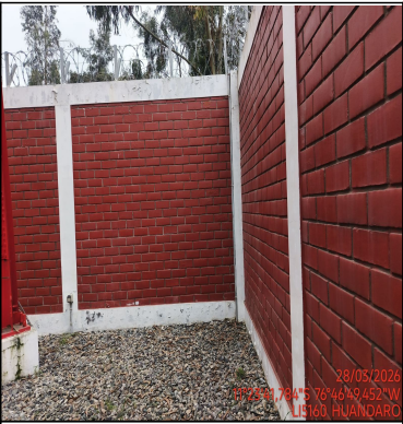
Foto Panorámica del Interior del Site
