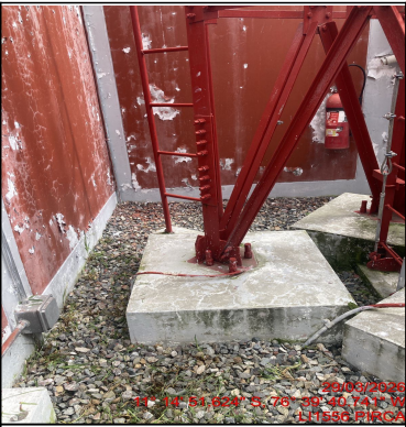
Foto Panorámica del Interior del Site
