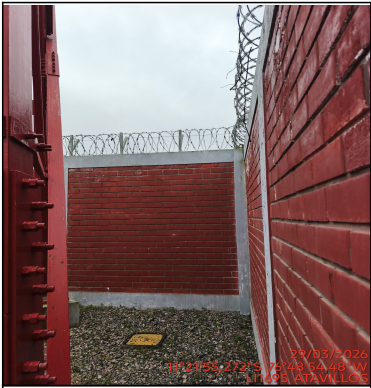
Foto Panorámica del Interior del Site
