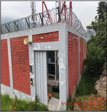
Pozo a tierra
