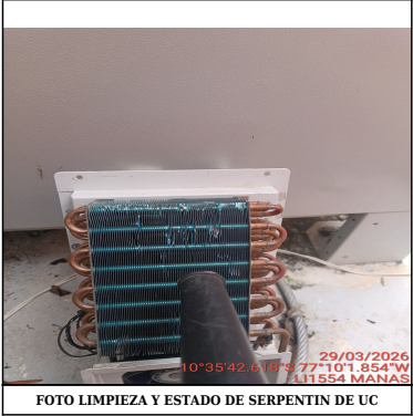
FOTO LIMPIEZA Y ESTADO DE SERPENTIN DE UC
