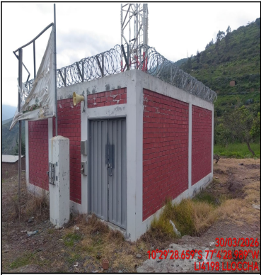
Pozo a tierra
