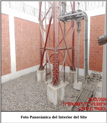
Foto Panorámica del Interior del Site
