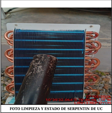
FOTO LIMPIEZA Y ESTADO DE SERPENTIN DE UC
