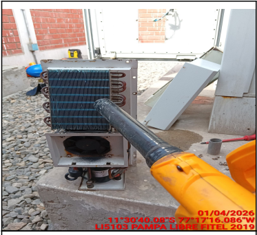
FOTO LIMPIEZA Y ESTADO DE SERPENTIN DE UC
