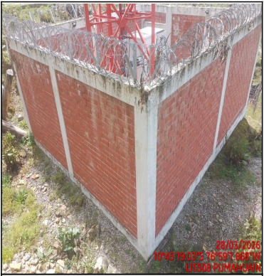
Pozo a tierra
