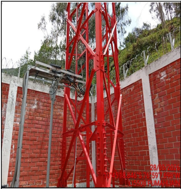
Foto Panorámica del Interior del Site
