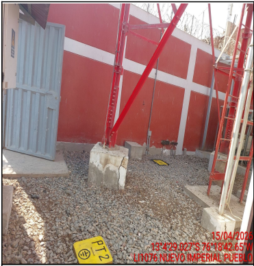
Foto Panorámica del Interior del Site
