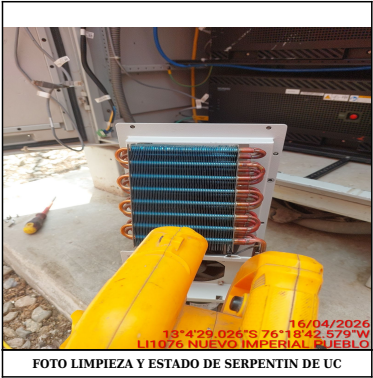
FOTO LIMPIEZA Y ESTADO DE SERPENTIN DE UC
