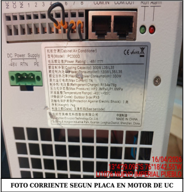
FOTO CORRIENTE SEGUN PLACA EN MOTOR DE UC
