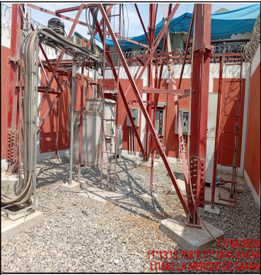
Foto Panorámica del Interior del Site
