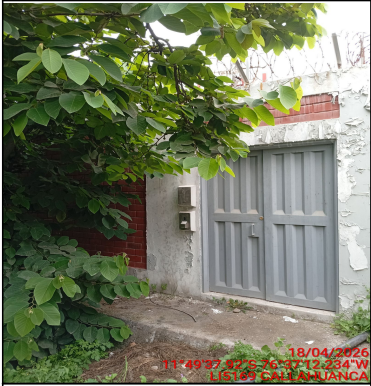
Foto Panorámica del Interior del Site
