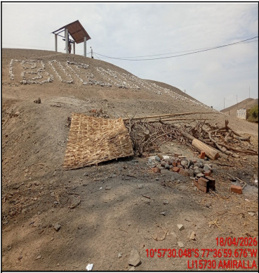
Pozo a tierra
