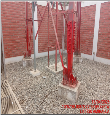
Foto Panorámica del Interior del Site
