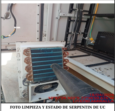
FOTO LIMPIEZA Y ESTADO DE SERPENTIN DE UC
