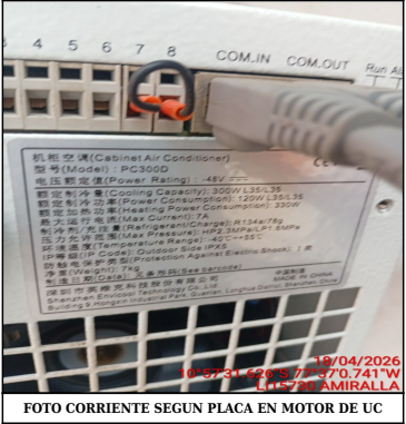
FOTO CORRIENTE SEGUN PLACA EN MOTOR DE UC
