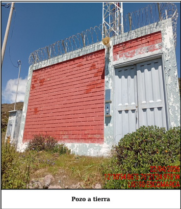
Pozo a tierra
