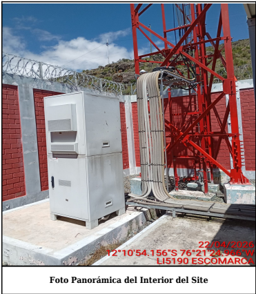
Foto Panorámica del Interior del Site
