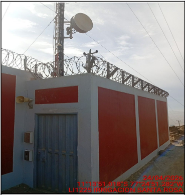
Pozo a tierra
