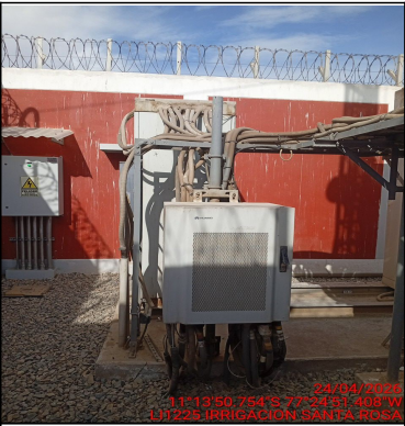
Foto Panorámica del Interior del Site
