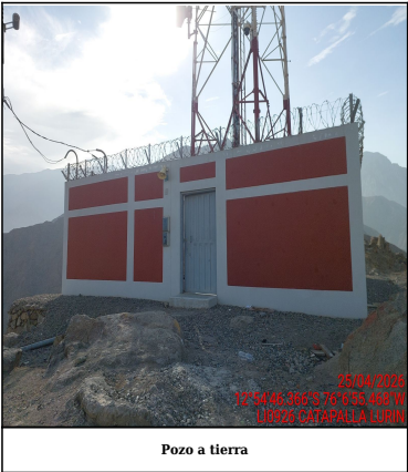
Pozo a tierra
