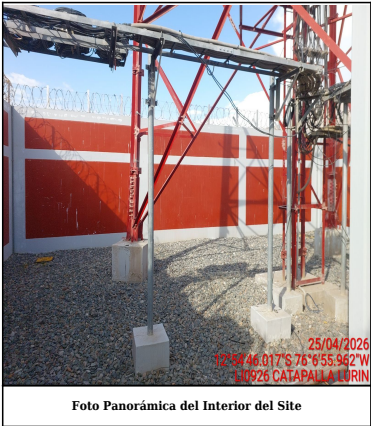
Foto Panorámica del Interior del Site
