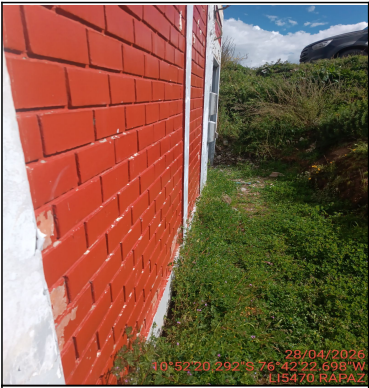
Pozo a tierra
