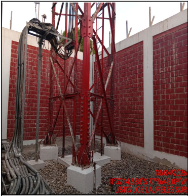
Foto Panorámica del Interior del Site
