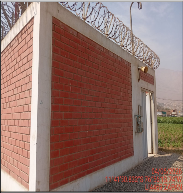
Pozo a tierra
