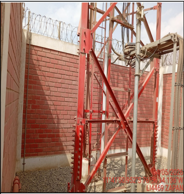
Foto Panorámica del Interior del Site
