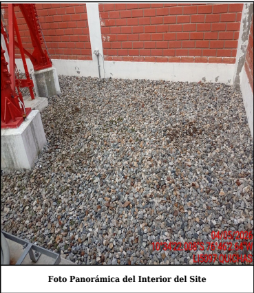
Foto Panorámica del Interior del Site
