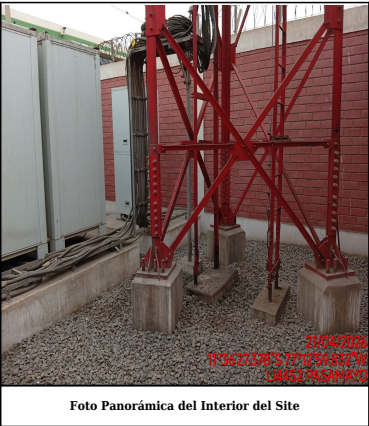
Foto Panorámica del Interior del Site
