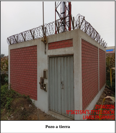
Pozo a tierra
