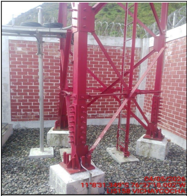
Foto Panorámica del Interior del Site
