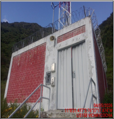
Pozo a tierra
