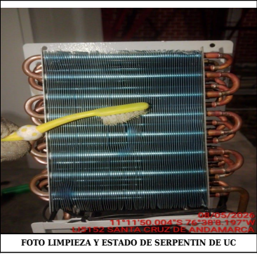
FOTO LIMPIEZA Y ESTADO DE SERPENTIN DE UC
