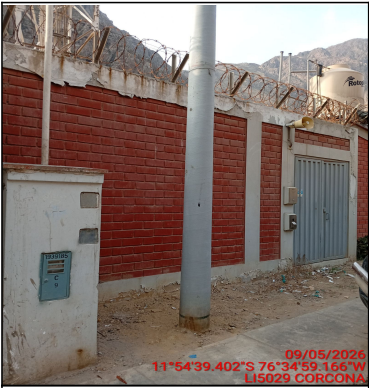
Pozo a tierra
