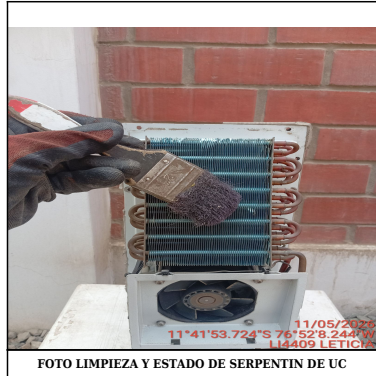
FOTO LIMPIEZA Y ESTADO DE SERPENTIN DE UC
