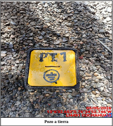
Pozo a tierra
