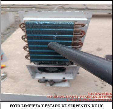
FOTO LIMPIEZA Y ESTADO DE SERPENTIN DE UC
