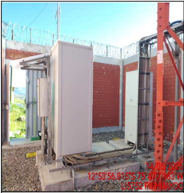
Foto Panorámica del Interior del Site
