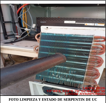
FOTO LIMPIEZA Y ESTADO DE SERPENTIN DE UC
