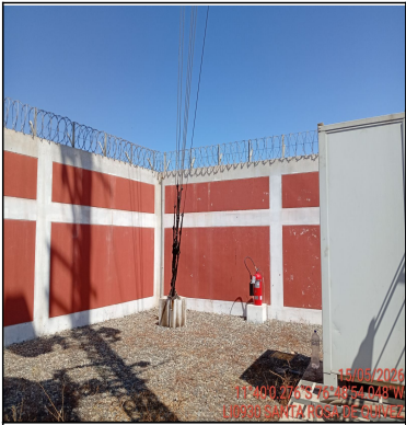
Foto Panorámica del Interior del Site
