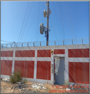
Pozo a tierra
