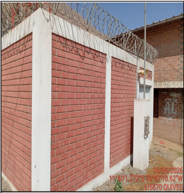
Pozo a tierra
